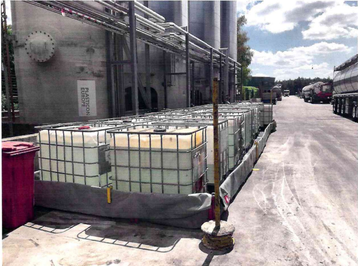
Bijlage 1: Opstelling IBC zwavelzuur in lekbak
