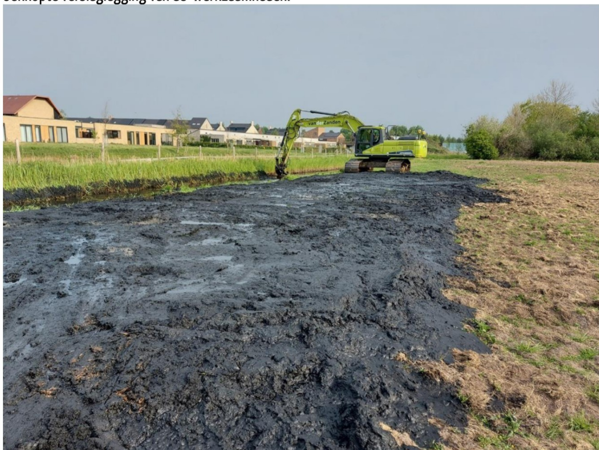
Figuur 1 Baggerwerk Oude Leij
